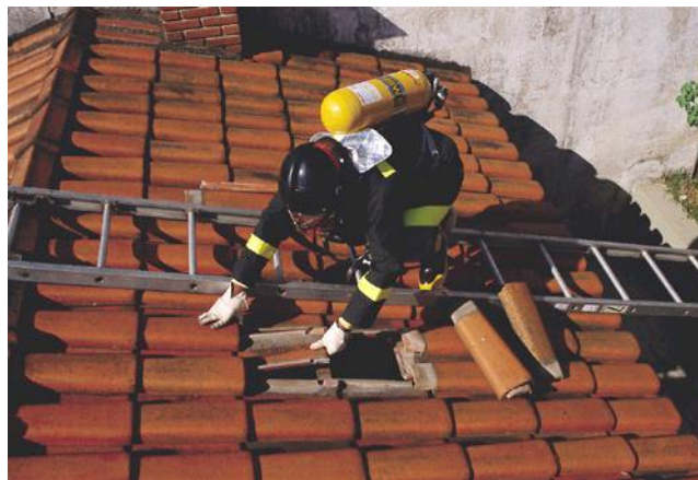
FIGURA 02 – abertura de telhado
