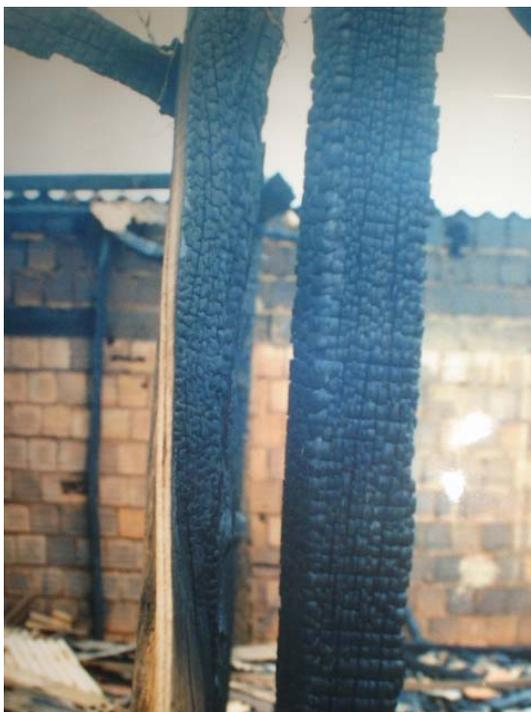
*Figura 5.8 - Marcas de crocodilo grandes, fundas e brilhantes indicam expansão rápida, talvez o uso de líquido inflamável.*
