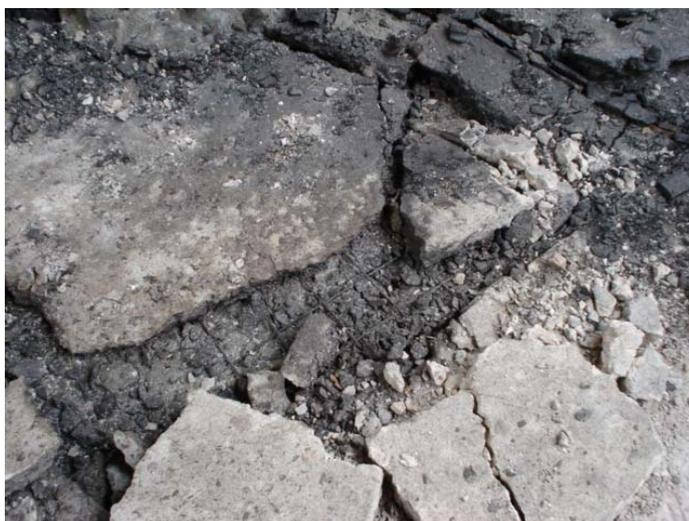
Figura 5.7 - Exame do embranquecimento do concreto na procura de acelerantes.
