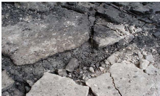
*Figura 6.9 - Concreto rachado e encaroçado poderia ser uma indicação de uso de líquido inflamável.*
