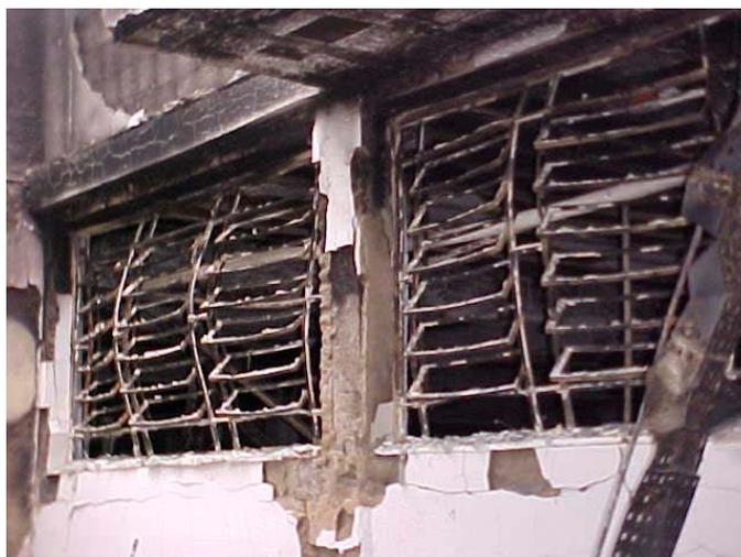
Figura 5.1 - Um exame do exterior revela marcas de auto-ventilação.
