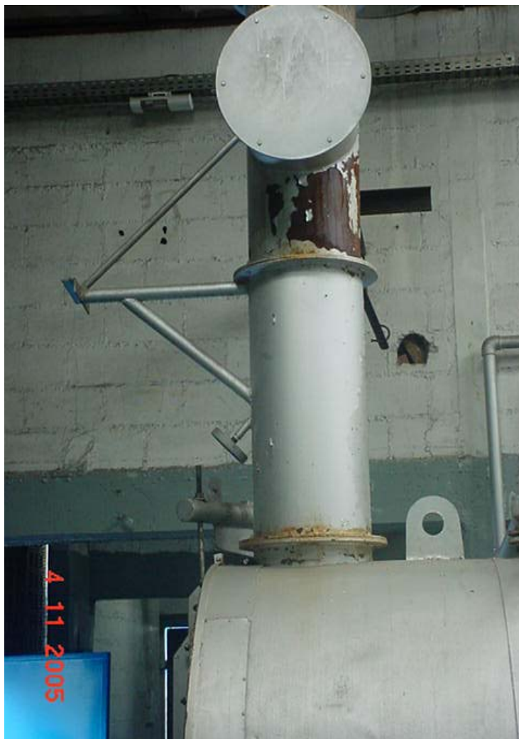
Figura 31 - Visualizador do nível de água
