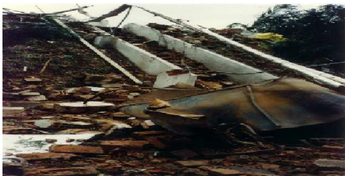
Fig 19 Destruição das linha de distribuição de vapor
