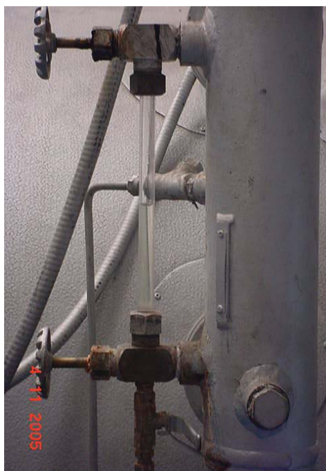
Figura 31 - Visualizador do nível de água
