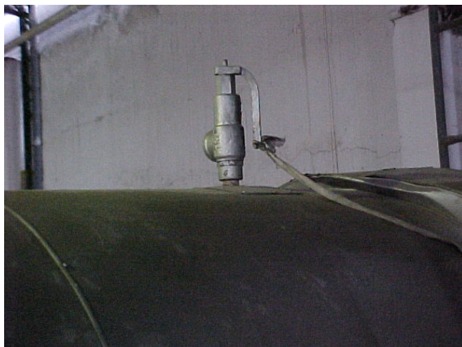
Figura 04 Válvula de segurança
