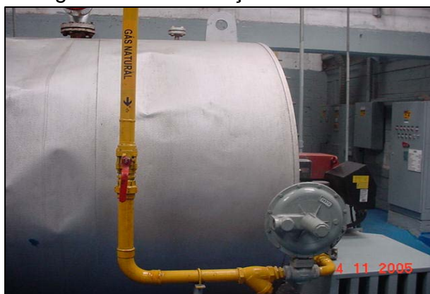
Figura 26 - Registro de alimentação
