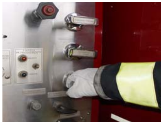
4- Abrir a válvula tanque-bomba, a válvula de abertura do tanque de espuma (Extrato de Espuma) e a válvula do edutor (Puxe para Espuma). Fechar a válvula de retorno para o tanque, evitando que a solução volte para o tanque.
