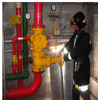
Figura 5.22 - Manobras na válvula de governo
