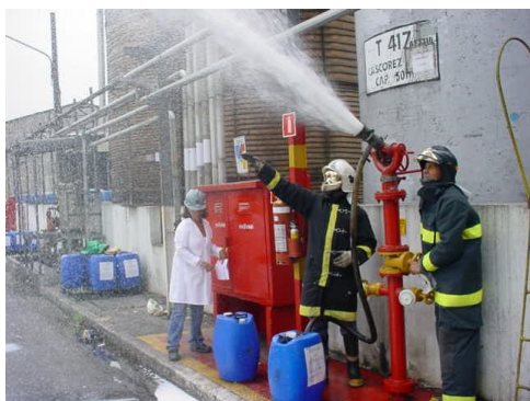
Figura 14.1 - Utilização de canhão monitor
