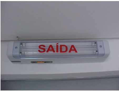
Figura 8.12 - Bloco Autônomo
