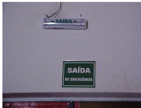
Figura 8.13 - Bloco Autônomo
