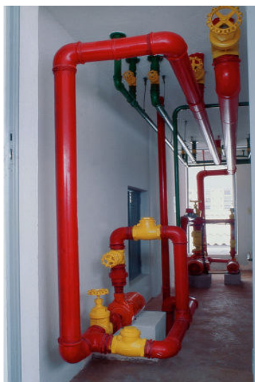
Figura 11.5 - Bomba de incêndio em reservatório elevado
