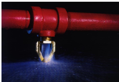
Figura 5.1 - Atuação do chuveiro automático
