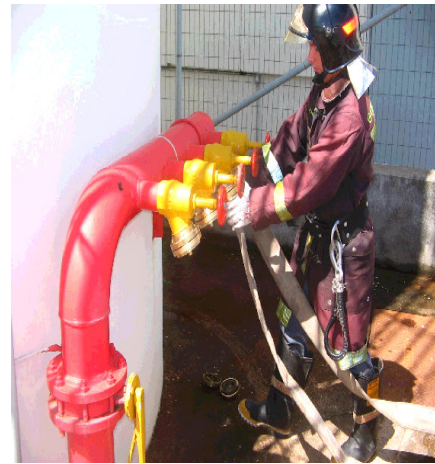
Figura 5.19 - Acoplamento da viatura ao registro de recalque
