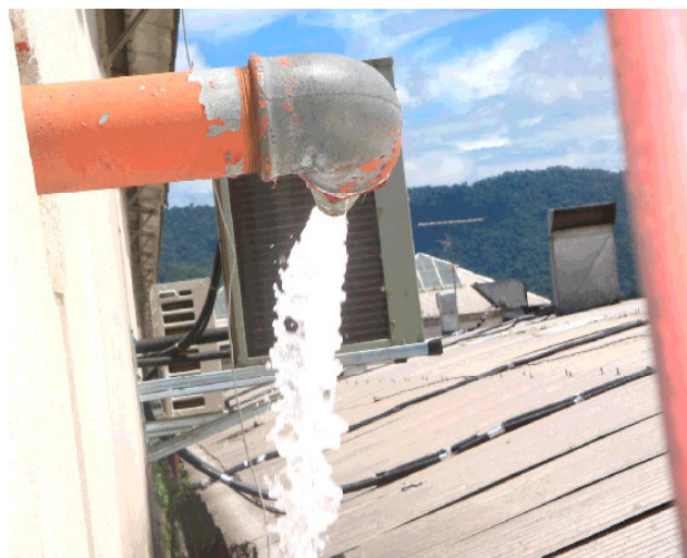
Figura 5.25 - Drenagem da tubulação
