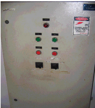
Figura 5.20 - Painel da bomba a explosão
