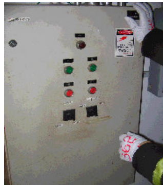
Figura 5.20 - Painel da bomba a explosão
