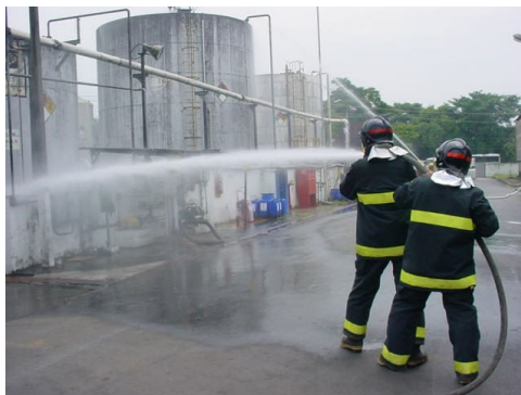
Figura 14.3 - Resfriamento nos tanques adjacentes
