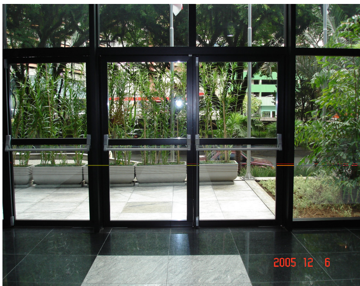
Figura 12.2 – entrada da edificação
