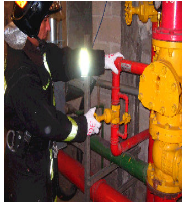
Figura 5.23 - Manobras na válvula de governo
