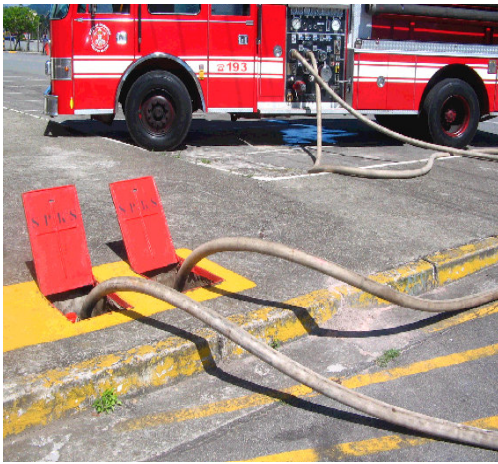
Figura 5.19 - Acoplamento da viatura ao registro de recalque
