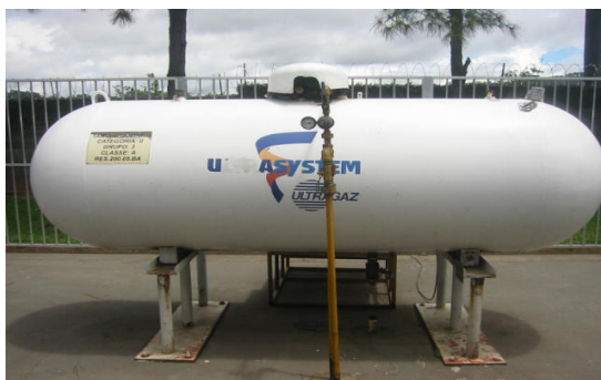
Figura 15.4 - Cilindro para armazenamento
