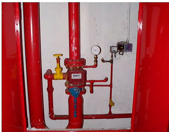
Figura 5.9 – Válvula de governo e alarme
