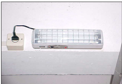
Fig. 8.1 - Bloco autônomo
