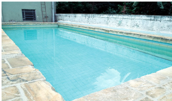
Figura 5.6 - Piscina usada como reserva de incêndio
